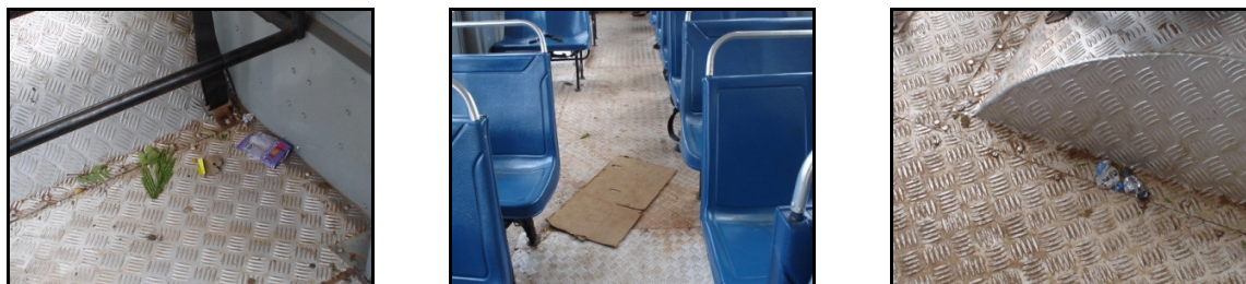
Figura 6.6: Condição de limpeza
