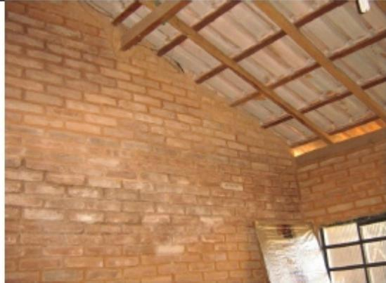
Foto 2: Vedações do telhado realizadas na lateral e na frente não.
