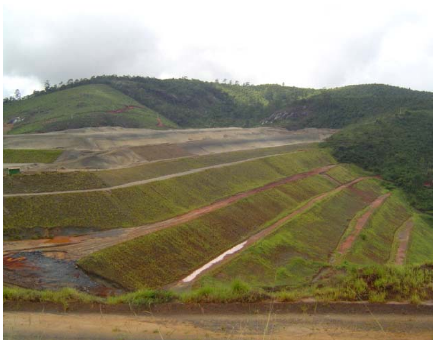
Figura 3.3 - Vista do talude de jusante da pilha do Monjolo (Santos, 2004)
