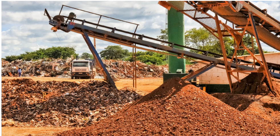
Figura 4 - Unidade de recebimento de entulho
