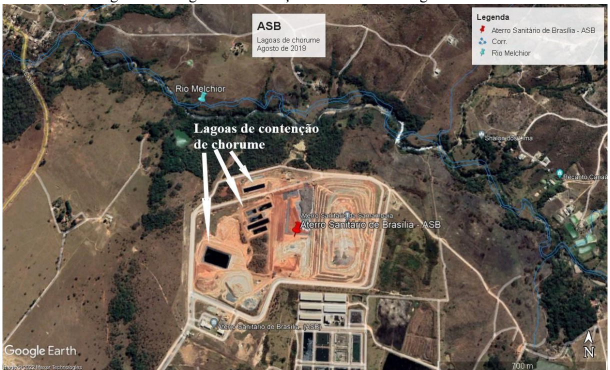
Figura 31 - Lagoas de contenção de chorume em agosto de 2019
