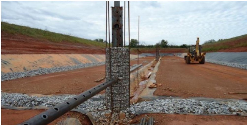
Figura 16 - Sistema de drenagem de gases
