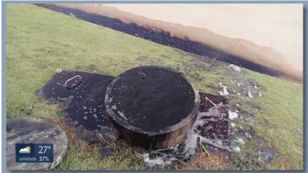
Figura 28 - Extravasamento de chorume em ponto de verificação
