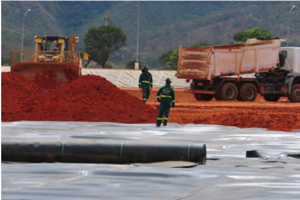
Figura 12 - Instalação geomembrana acima de terreno compactado no ASB
