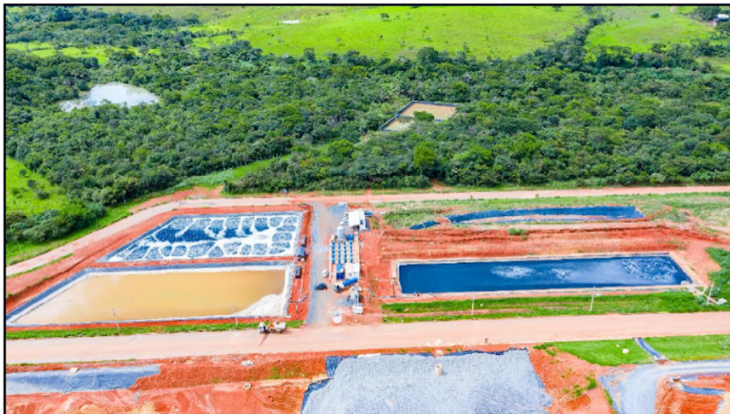
Figura 22 - Estação de tratamento de chorume do ASB
