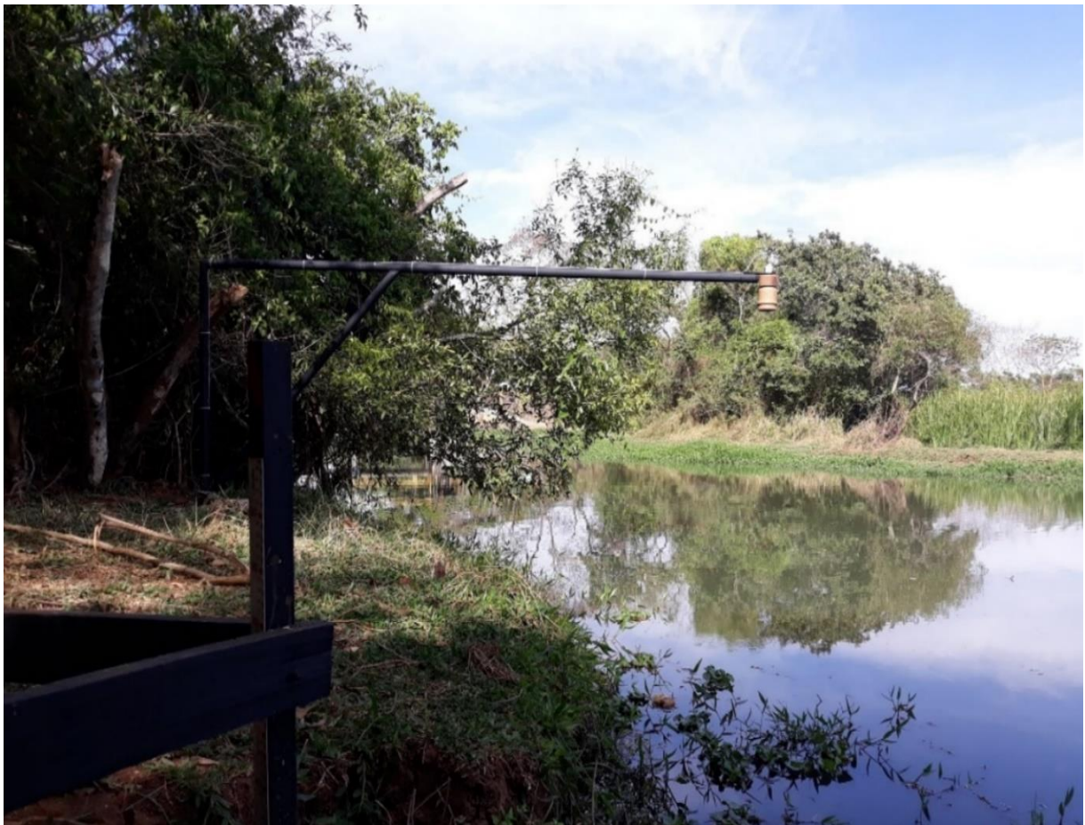
Figura 6 – Estação telemétrica de monitoramento fluviométrico
