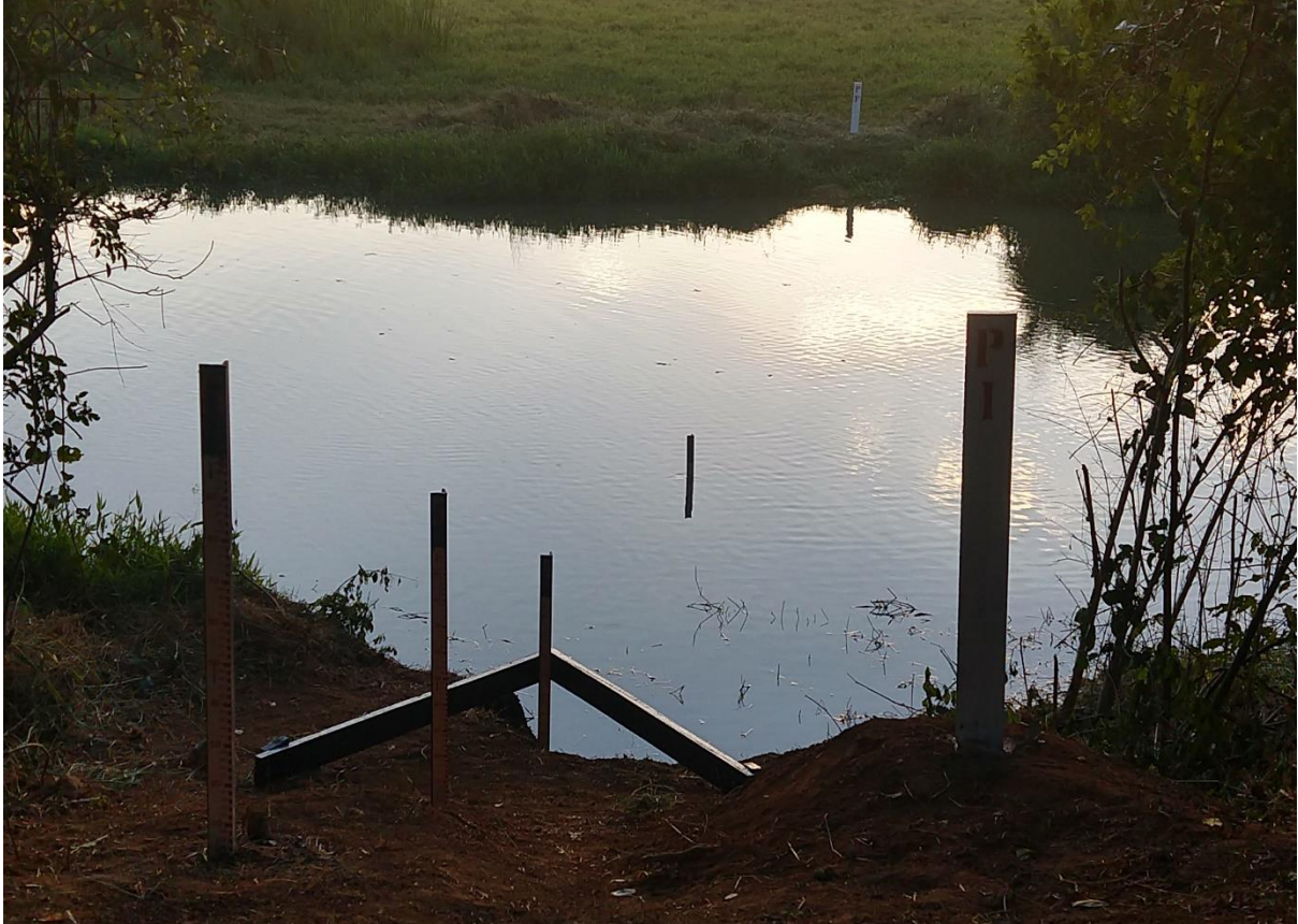
Figura 3 – Estação fluviométrica seção de réguas limnimétricas
