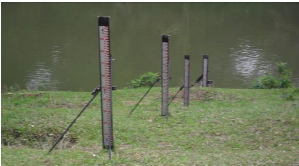
Figura 12 – Exemplo de régua instaladas seguindo os padrões da ANA
