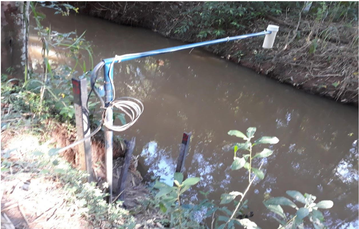
Figura 18 – Sensor de nível ultrassônico instalado na estação monitoramento fluviométrico – Cap. Itauçu
