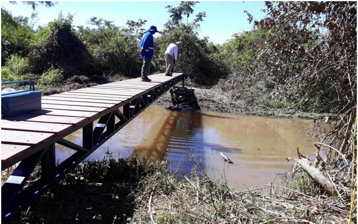
Figura 17 – Passarela instalada a montante da estação monitoramento fluviométrico – Cap. Inhumas
