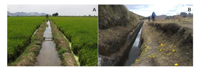
Figura 16. Modelos de canais de irrigação da costa norte do Peru: em baixa altitude para irrigação de campos de arroz no Vale do Jequetepeque (A); e em altitude, esculpido na rocha para transportar água dos terrenos altos para os vales, no departamento de Cajamarca (B). Fonte: Fotografias da autora (julho/2016).
