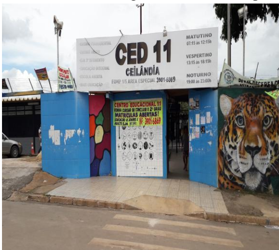
Fachada da escola
