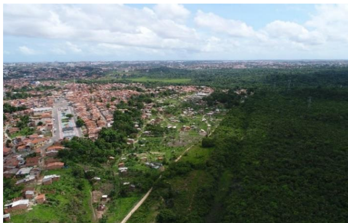
Figura 38: Ocupações irregulares no PE do Bacanga, São Luís – MA. Fonte: autor, 2018.
