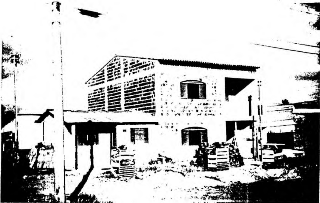
Foto 02 - Casas em construção na Candangolândia Candangolândia - A casa à esquerda passou por poucas melhorias, foi rebocada com cimento e as janelas foram mudadas. A casa à direita passa por total reforma, na verdade está sendo construída.
