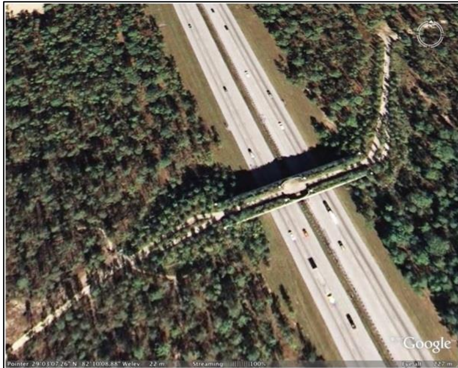
Figura 7 - Passagem de Fauna na Interestadual 75 Marion County, Florida, EUA. Fonte: CLEVENGER & HUIJSER, 2011 a partir do Google Earth.
