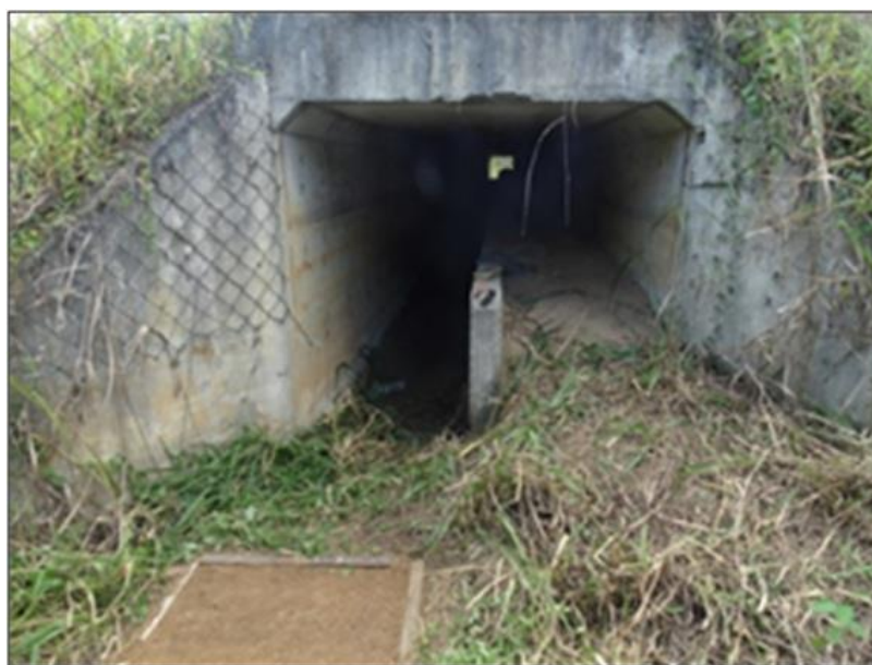
Figura 4 - Passagem de Fauna em Bueiro com passagem seca na rodovia BR-101/NE. Fonte: DNIT, 2016
