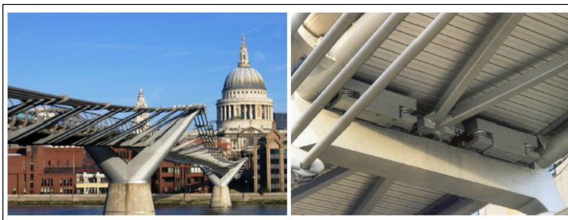
(a) Vista da ponte
