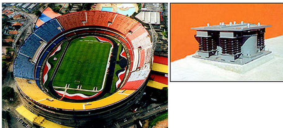
Figura 1.3 – Sistema de controle adotado no estádio Morumbi de São Paulo (Gerb, 1998).
