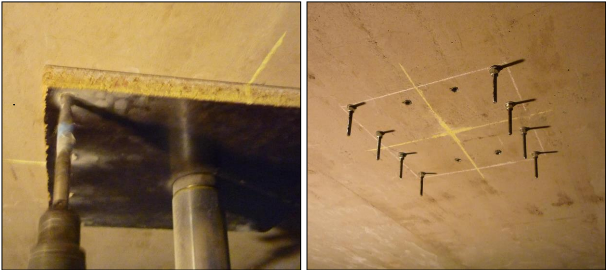
Figura 5.71 – Chumbadores de aço ancorados na laje de concreto.
