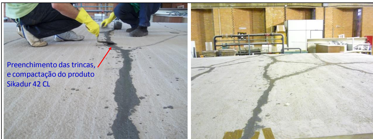
Figura Anexo II.12 – Preenchimento das trincas com produto Sikadur 42 CL
