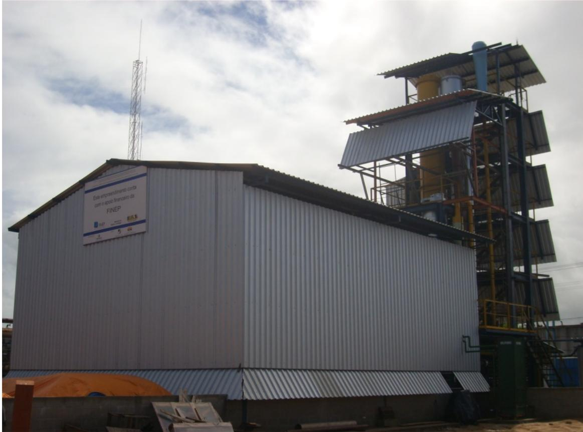
Figura 1.2 – GASLIN. Planta de gaseificação em leito fluidizado circulante localizada em Linhares – ES.
