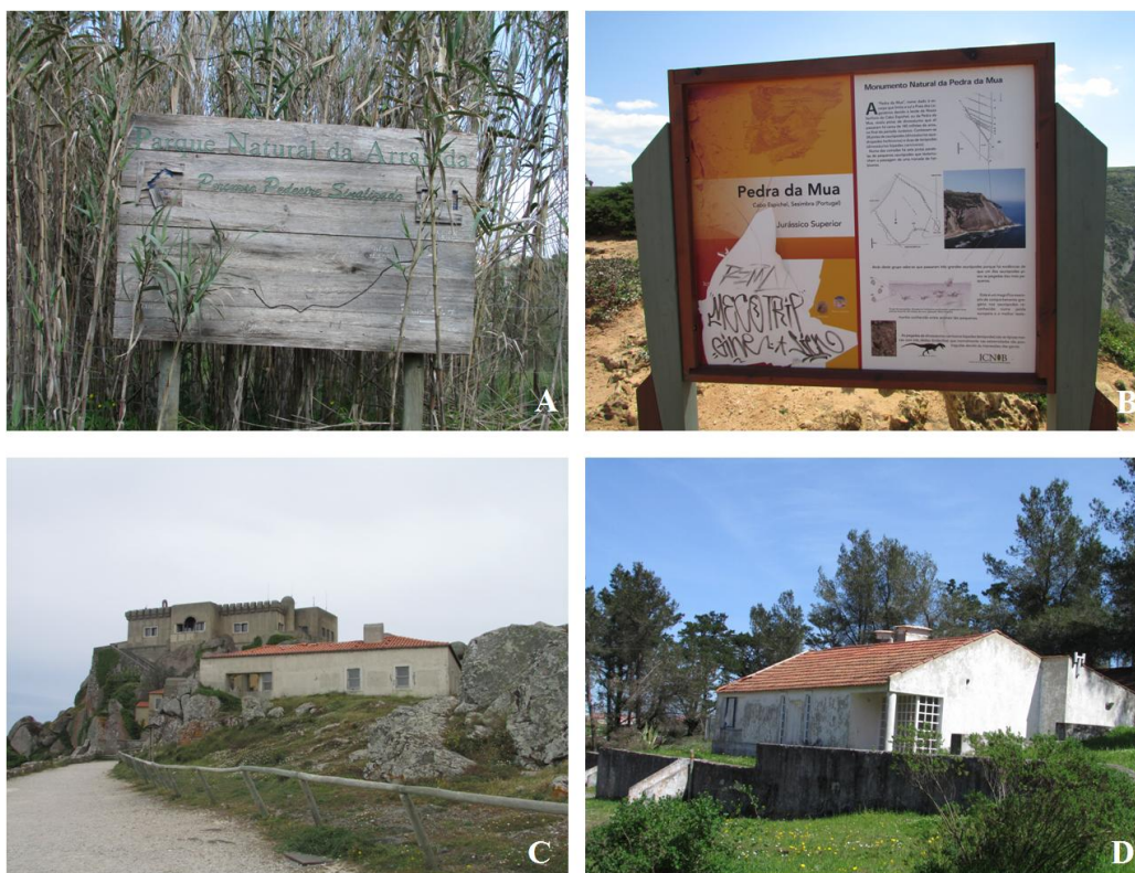
Figura 3.7 – Infraestrutura de apoio em mau estado de conservação e sem utilização. A e B – Placas deterioradas no Parque Natural da Arrábida, C – Centro de educação ambiental do Parque Natural Sintra-Cascais (fechado), D – Alojamento do Parque Natural das Serras de Aires e Candeeiros (fechado).
