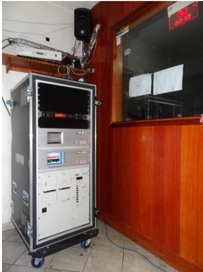
Figura 47 – Visão do transmissor HD Radio (esquerda), e Detalhe da tela do gerador de sinal digital (direita).
