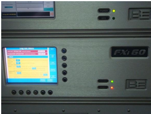
Figura 48 – Detalhe do excitador (esq.) e dos amplificadores (dir.).
