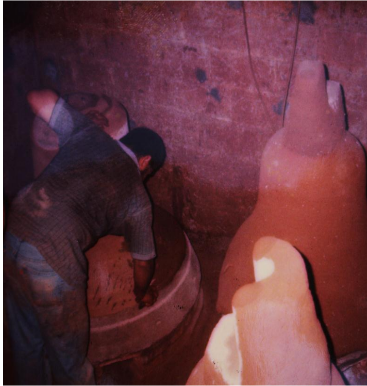
Figura 84. Cobertura do perfil para reforço da 1ª fêmea, formação da 2ª fêmea. Fonte: fotografia do acervo da FASU
