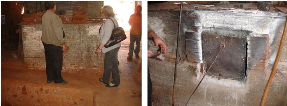
Figura 91 e 92. Fornalha frente ao buraco. Fonte: fotografadas na visita de 20/07/2012
