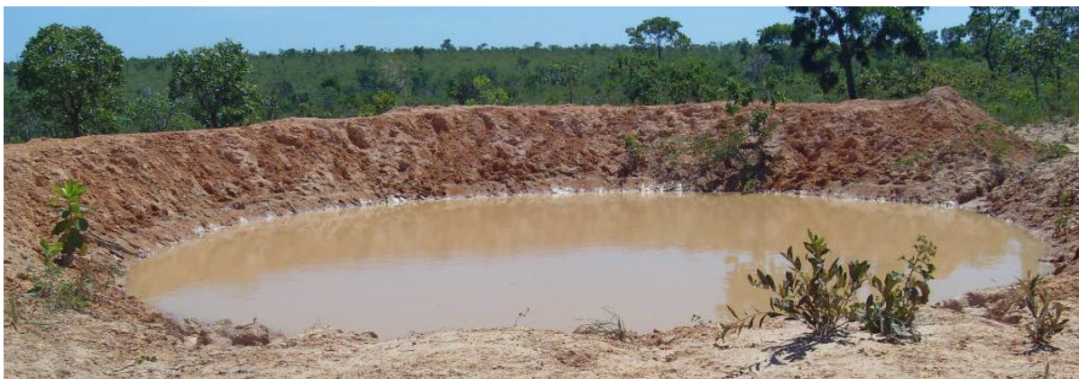
Figura 21: Exemplo de barragem. Localização Reserva de Desenvolvimento Sustentável Veredas do Acari. Esta foi construída para conter a processos erosivos originados pelas estradas carreadoras das antigas plantações de eucalipto. Foto: Sílvia Laine Borges Lúcio (2012).
