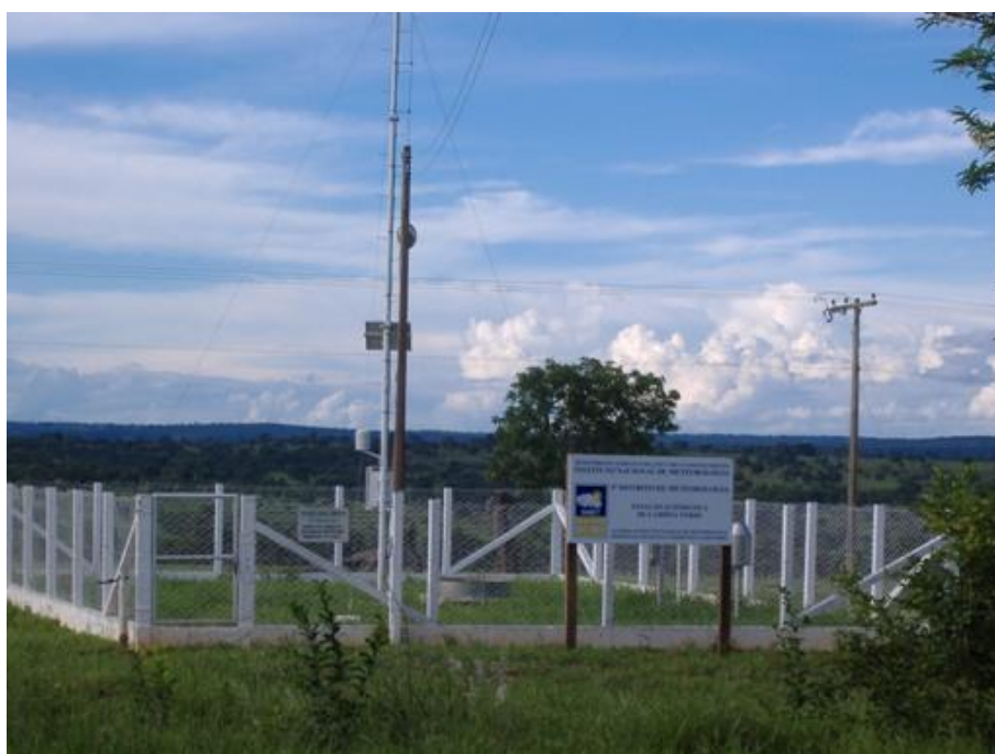
Figura 3-11: Estação Meteorológica Automática – EMAS , sensores, mastro com caixa data-logger, painel solar, cercado.
