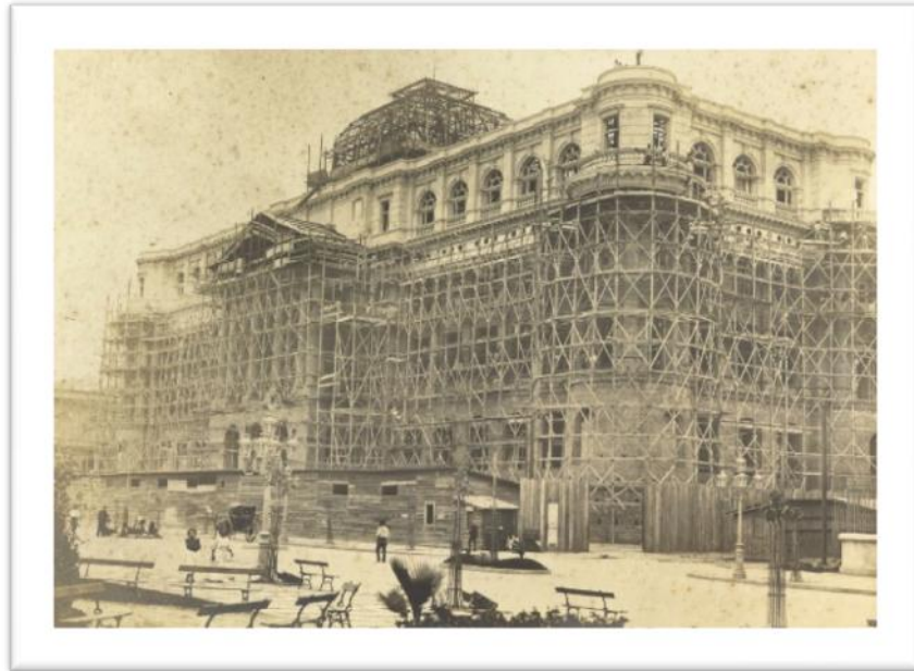
Figura 2- Foto da construção do prédio da Vista frontal, 1909.
