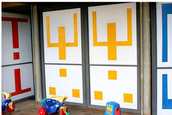
**Ilustração 67** - Portas pivotantes com pintura especial no hospital Sarah Asa Sul. (Foto: Ricardo Padue)
