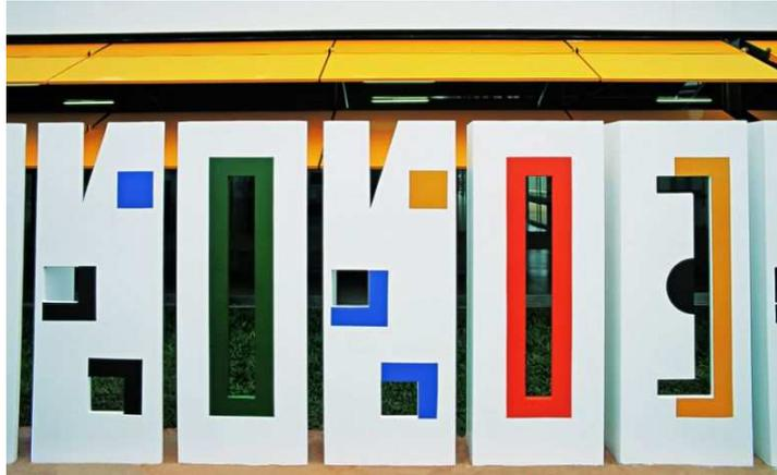
**Ilustração 75** - Muro vazado em Argamassa armada na lateral da edificação principal do complexo do hospital Sarah Lago Norte (Foto: Tuca Reinés).<sup>70</sup>
