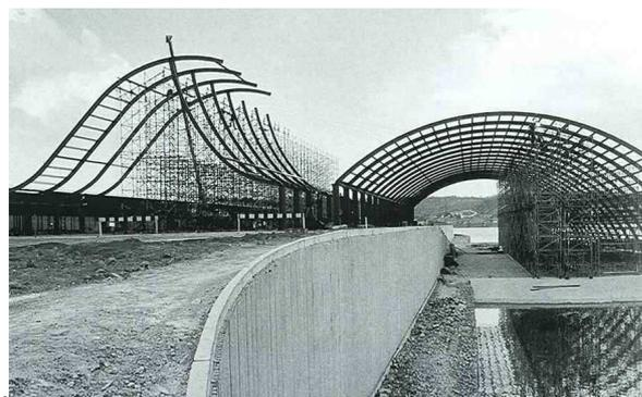
**Ilustração 40** - Sistema construtivo: montagem dos Sheds do Hospital Sarah Centro de Reabilitação Lago Norte.<sup>60</sup>
