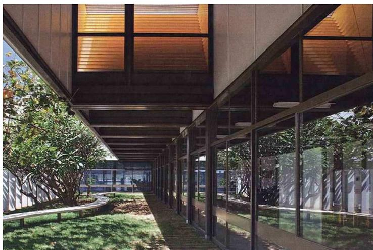
**Ilustração 50** - Aberturas, ventilação e iluminação no jardim lateral do hospital Sarah Kubitschek Asa Sul.
