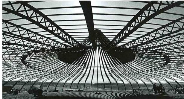
**Ilustração 39** - Estrutura do Ginásio, vigamento duplo, apoiado em pilares metálicos de seção circular.<sup>59</sup>
