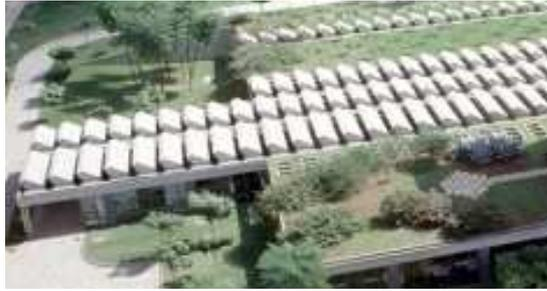
**Ilustração 69** – Sistema de ventilação “Sheds” na cobertura do hospital Sarah Asa Sul.
